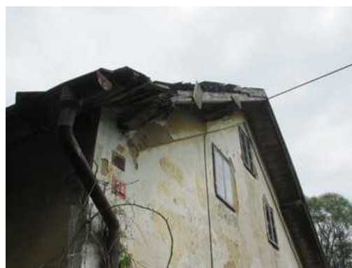
zhoršený technický stav
