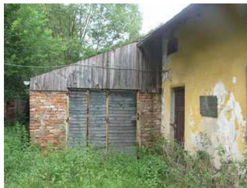
přístavba k RD
